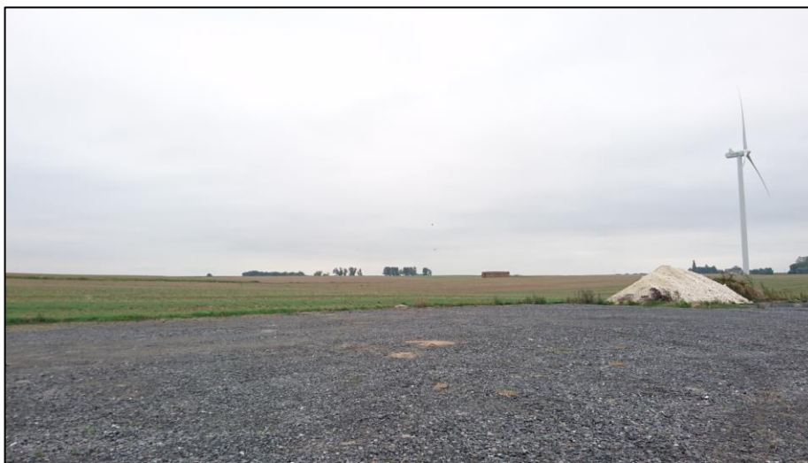
Figure 2 : Illustration d'un sol minéral appliqué à une plateforme de montage
